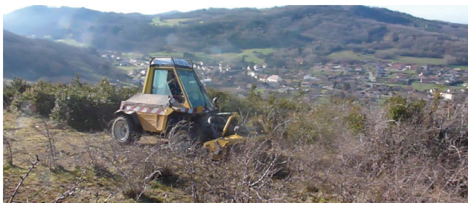
Une entreprise jurassienne est intervenue pour réaliser des travaux de réouverture sur 5,5 ha en hiver 2016. Un tracteur de pente monté sur pneus basse pression a été utilisé permettant de limiter l'impact au sol.
